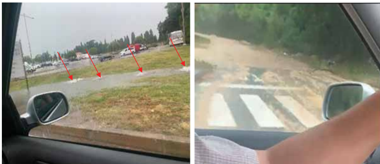
Slika 12. Preljevanje šahtova odvodnje s parkirališta za vrijeme intezivnih padalina (10/2025.)
