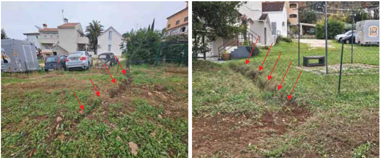
Slika 15. Iskopani kanal – jarak za oborinsku vodu na među sa susjednom parcelom
